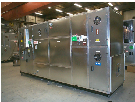
Aggregat provtryckt och klart för leverans.
